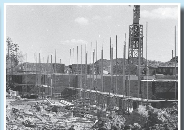
Oversigtsbillede af byggepladsen
