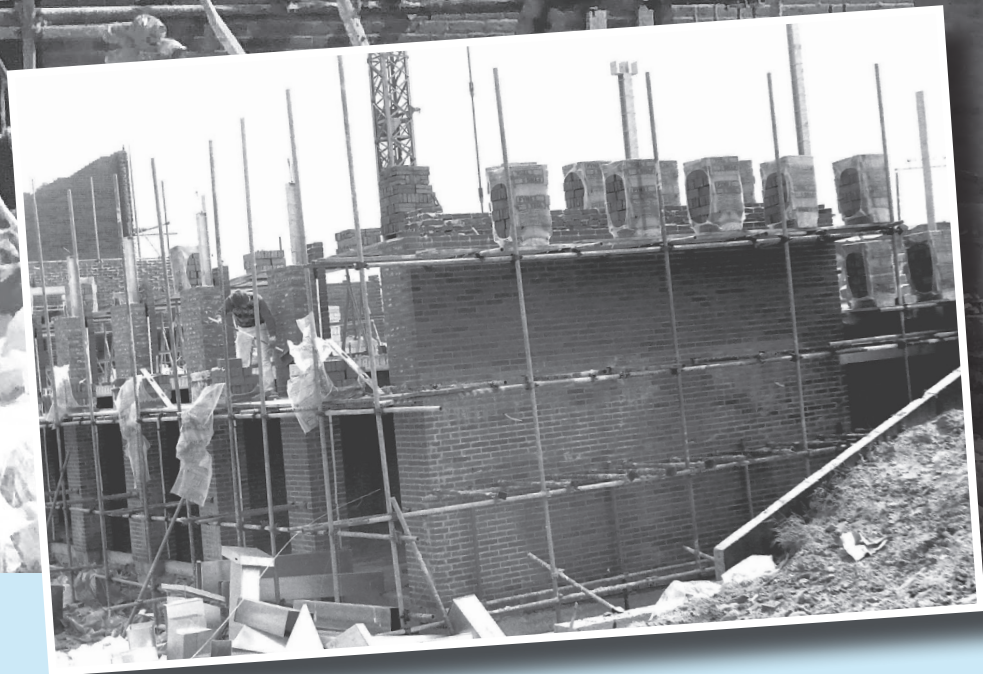
Tydeligt en-søjlet scan-rørstillads – fastgørelser.... Mjhhh
